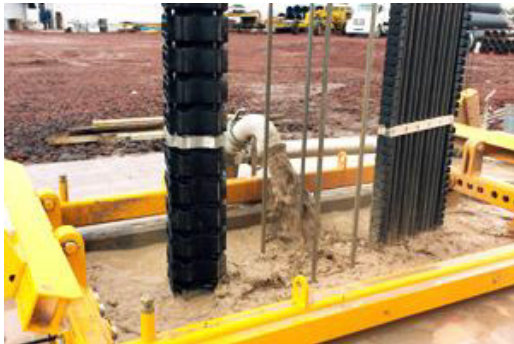
Inyección de lodo bentonítico en excavación.
