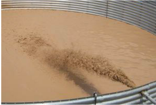
Contenedor de lodo bentonítico.
